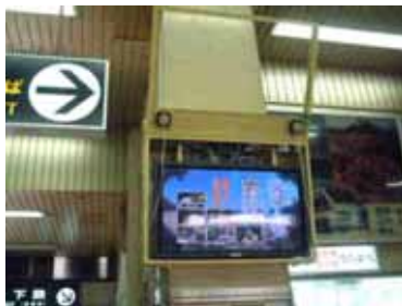
現地調整中。カバーをあけた状態。
